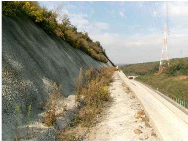
1소단 배수로 전경
